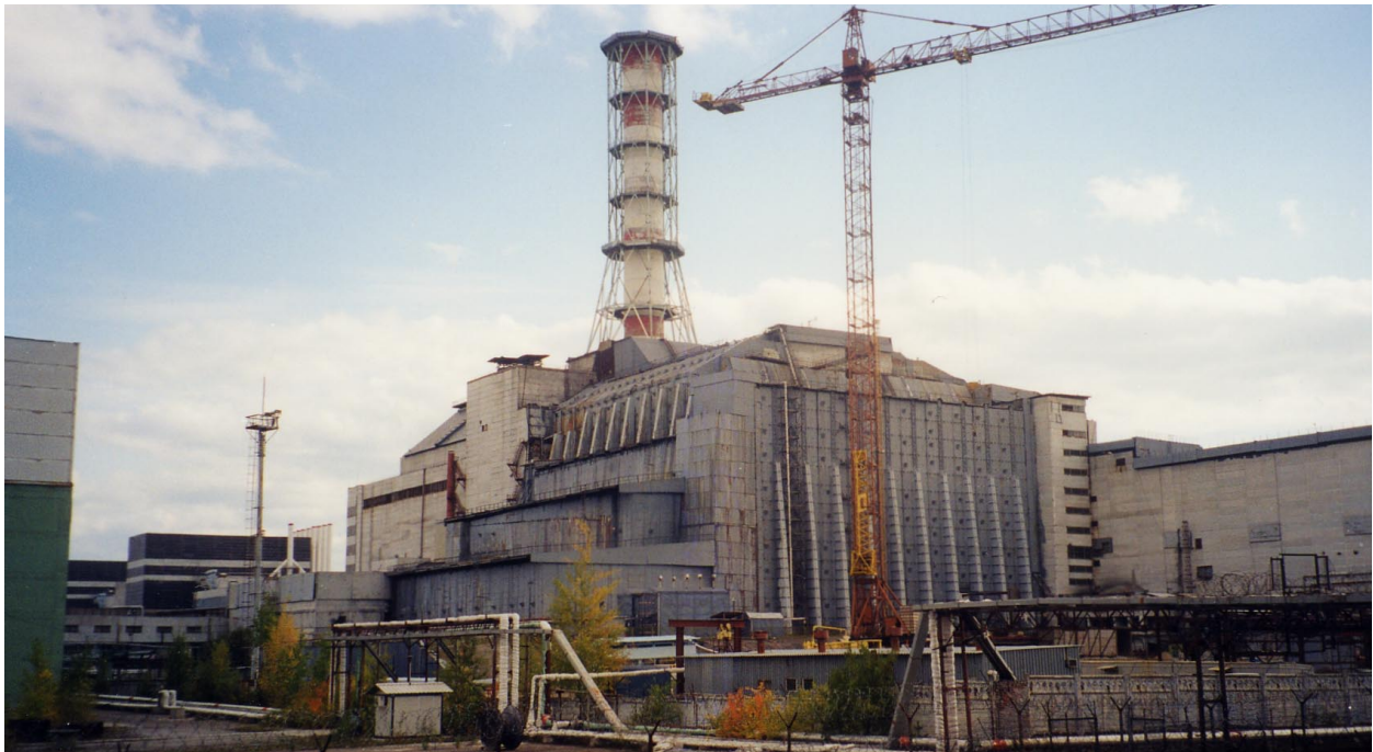
Abbildung 4: Nach der Explosion wurde das gesamte Reaktorgebäude mit einem Sarkophag aus Beton umhüllt, damit kein radioaktives Material mehr in die Umwelt gelangt.
